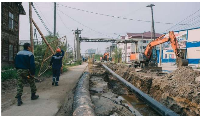
Рисунок 1. Вскрытие дорожного полотна для замены устаревшего газопровода по улице Чайковского, г. Якутск
