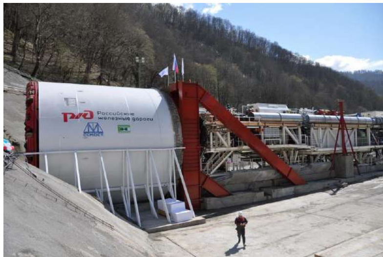
Рисунок 2. Пуск ТПМК Herrenknecht 10690 на строительстве тоннельного комплекса трассы Адлер - Альпика-Сервис, 2010г.
