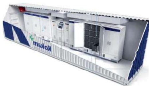
Рисунок 1. Модуль сетевого накопителя в разрезе
